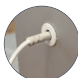
Zabezpieczone wejście na kabel
