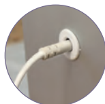
Zabezpieczone wyjście na kabel
